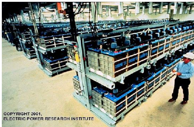
Σχήμα 2.1: Συστοιχία μπαταριών μολύβδου – οξέος μεγάλης κλίμακας
