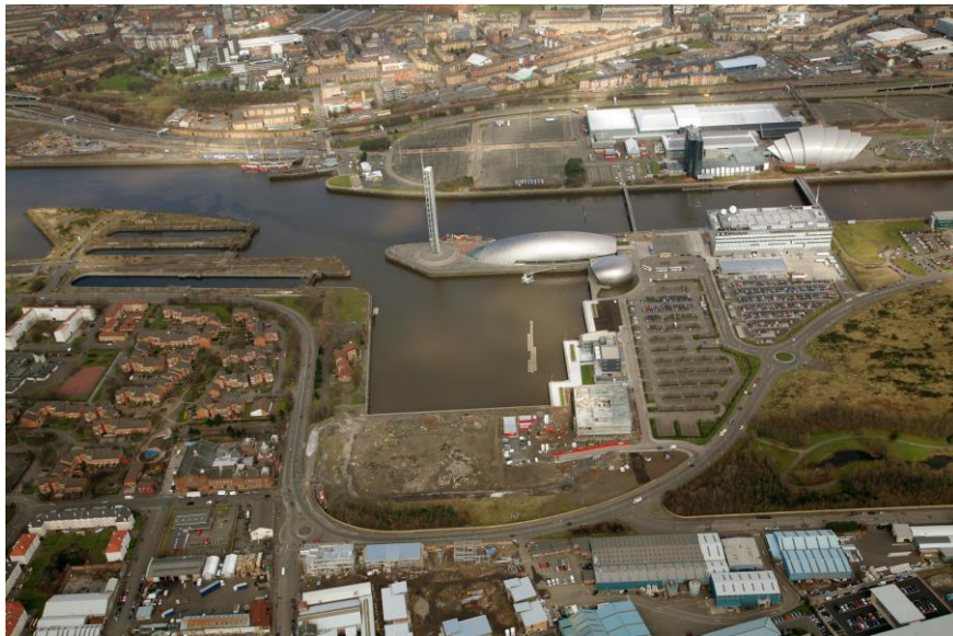
Εικόνα 34: Γενική άποψη του επικέντρου σήμερα (πηγή: www.thedrum.com/news/2008/10/21/glasgow-digital-quarter-launch&ei=f8pNVbv8MIKxUZfTgOgB&bvm=bv.92885102,d.bGg&psig=AFQjCNGdr_g__Evi5tnHXoGlnzBBeeR3MwQ&ust=1431247551509809 )
