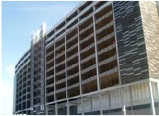
Εικόνα 24: Το κτίριο στάθμευσης (πηγή: http://www.sccltd.co.uk/mediacity.html )
