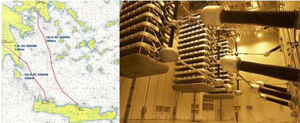
Εικόνα 7.2 Σενάρια για την διασύνδεση της Κρήτης [51] και φωτογραφία από αντίστοιχο σταθμό [52] όπου διακρίνονται οι ακροδέκτες των τριών φάσεων, οι συστοιχίες θυρίστορ και (χρήσιμο για λόγους προοπτικής του μεγέθους) ένας εργαζόμενος.
