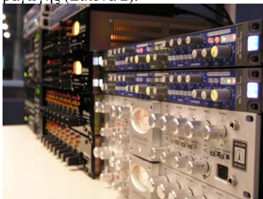
Εικόνα 2: Εξοπλισμός control room.
